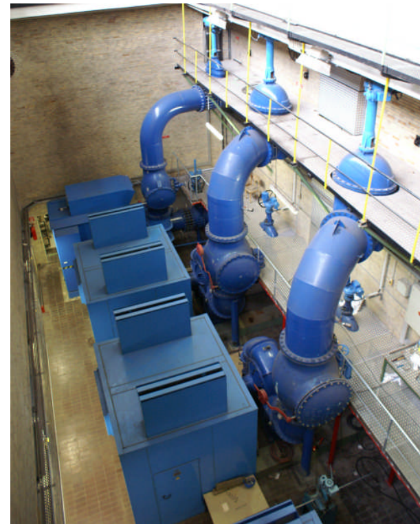
Pumpwerk Hamburg Landungsbrücken zum Transport der Hamburger Abwässer über die Elbe zur Kläranlage Köhlbrandhöft
