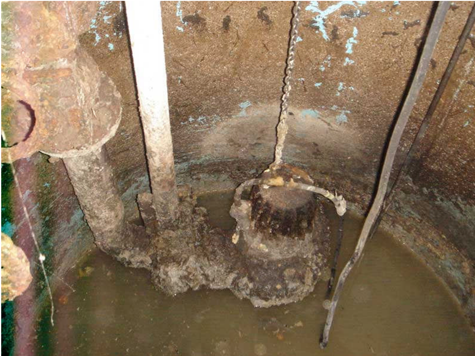
Bild: WET Wassertechnik GmbH
