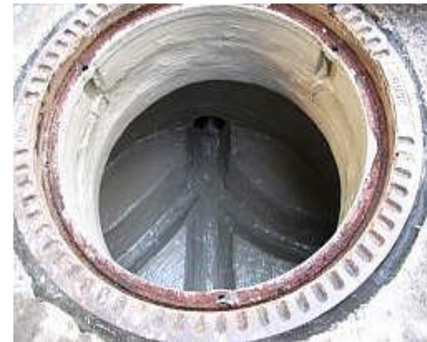
Zementmörtelbeschichtung mit Dickenmessung (ca. 20 mm)
